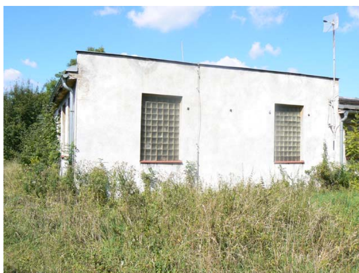
Obrázek 4 až 6 – DVOUPODLAŽNÍ PŘÍSTAVBA A ZADNÍ TRAKT OBJEKTU Č.P.2526
