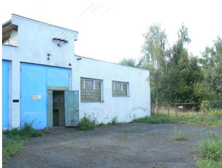
Obrázek 1 až 3 - VÝCHODNÍ POHLED NA OBJEKT Č.P.2526
