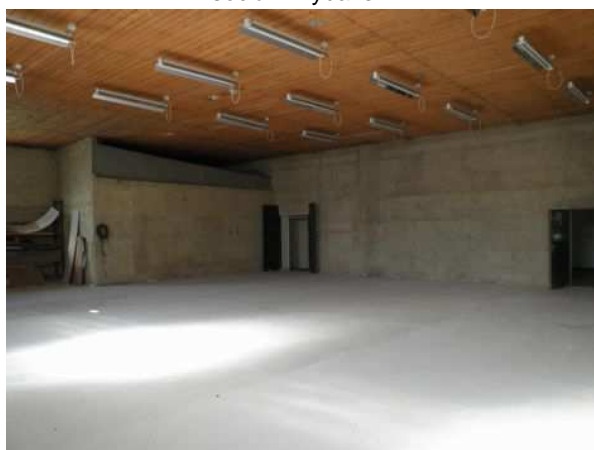
interiér - výrobní a skladovací hala
