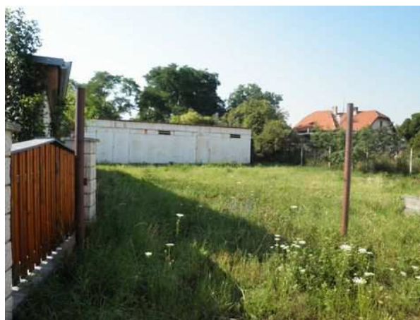
Pohled z ulice na plech. halu a dvůr
