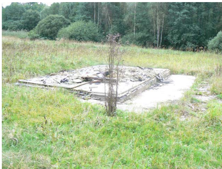
Obrázek 3 – SV POHLED NA DEMOLOVANOU CHATU NA POZEMCÍCH ST.P.Č.339/1 A 339/2
