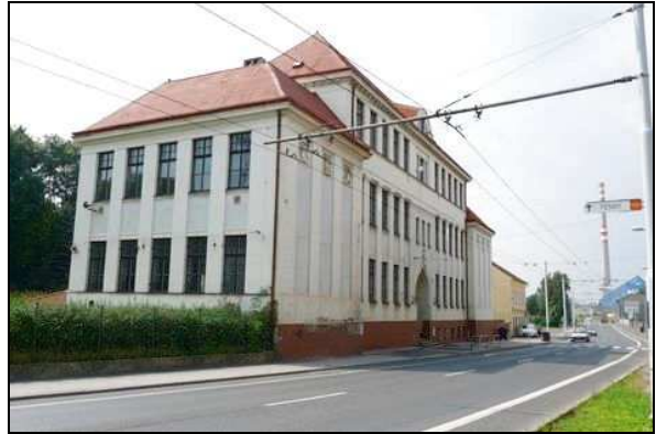
pohled z ulice – severovýchodní
