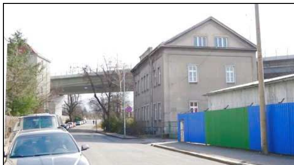
pohled z ulice - severozápadní
