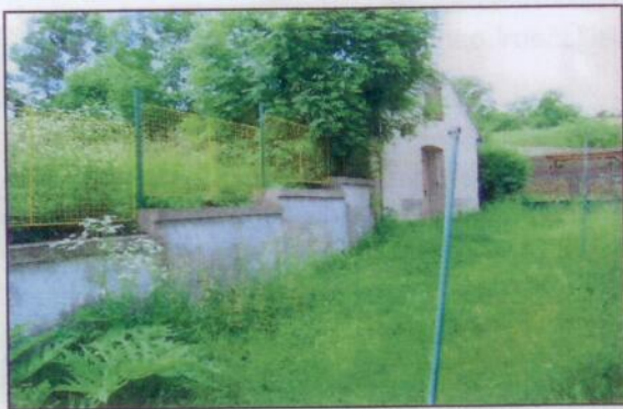
Dvůr a vedlejší stavba za budovou
