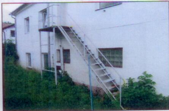
Zadní strana budovy - požární schodiště
