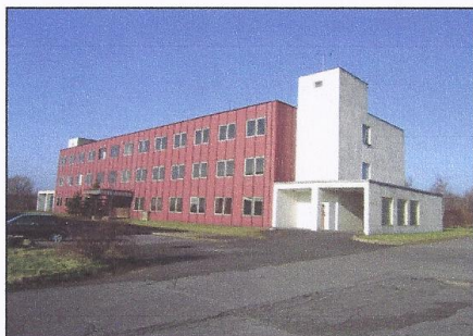
Budova na stp.4071/49 - pohled od jihozápadu
