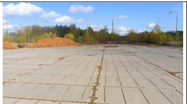
nádvoří - montované zpevněné plochy
