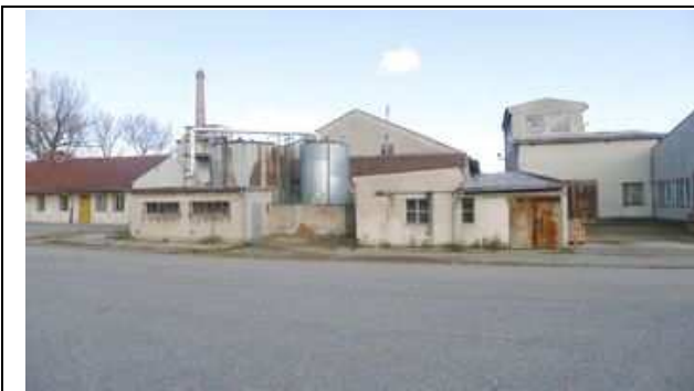
mazutové hospodářství - vpravo kotelna
