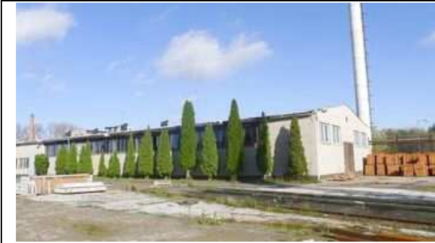
objekt cihelny - pohled jižní
