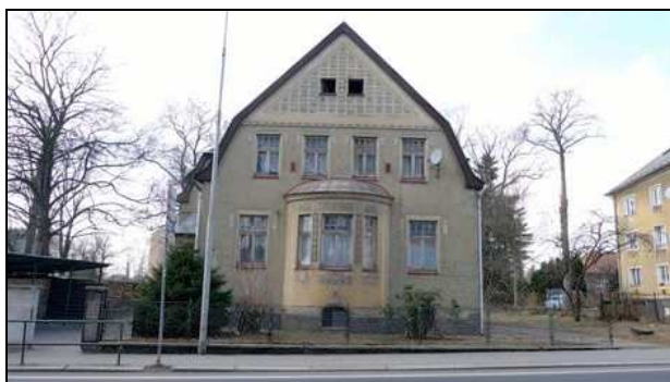
pohled z ulice - východní - hlavní průčelí
