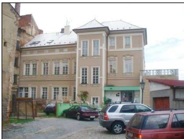
pohled jižní - čelní
